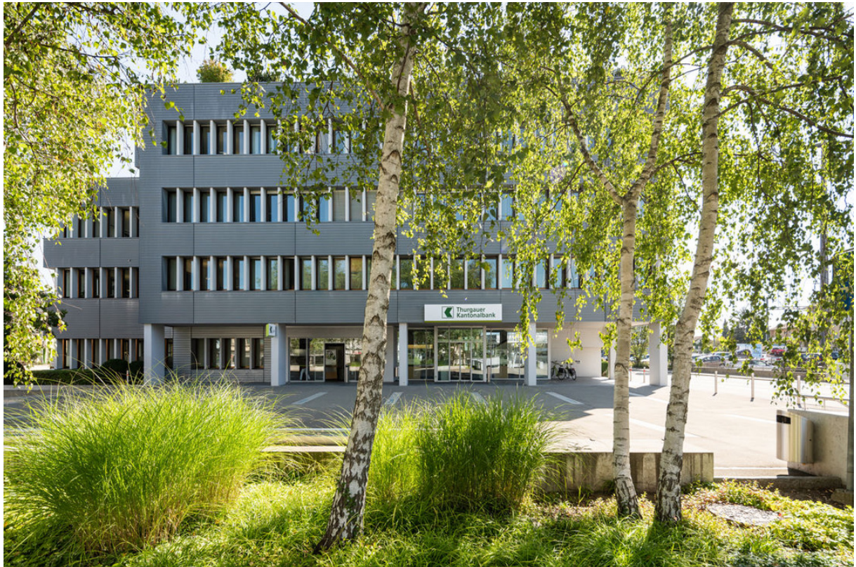
Der Hauptsitz der Thurgauer Kantonalbank in Weinfelden (Bild:TKB)
